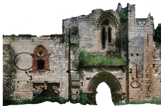
Fachada sur con la ubicación de los tres relojes de sol
