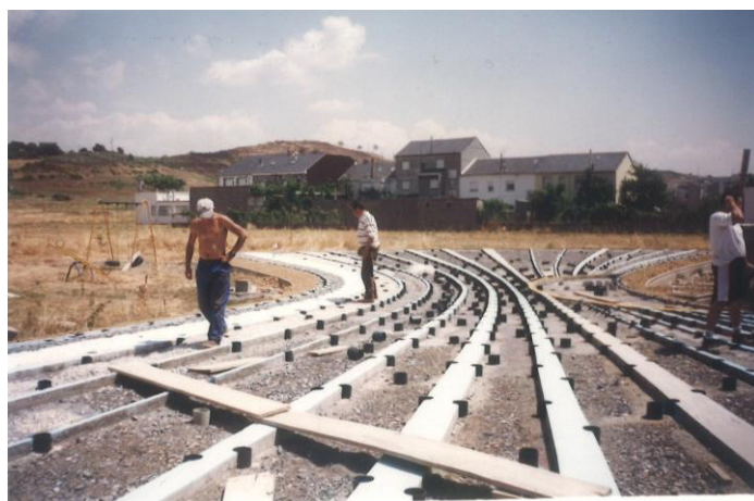
Figura 4. Construcción del reloj-calendario en Bembibre. Se aprecian muy bien las hipérbolas de las fechas. Son los bordes de esas bandas de hormigón. Se tuvo en cuenta el efecto de la refracción. En las horas centrales del día y en fechas próximas al solsticio de verano se interrumpió el trazado.
